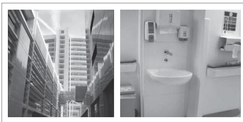
写真2 ロンドン大学病院では、新築の際595床に対して、1,200箇所の手洗い設備を設けている。
